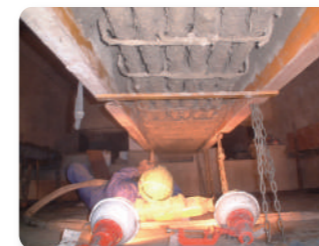
主桁底面増厚補強
