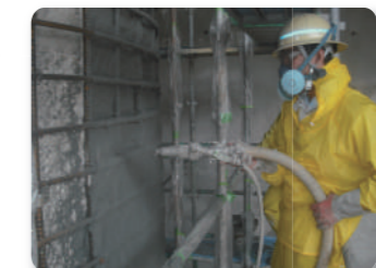
橋脚吹付け施工(耐震補強工)
