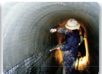
水路トンネルコテ塗り施工
