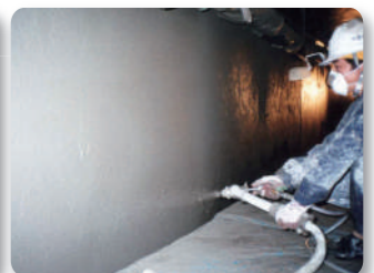
側壁吹付け施工
