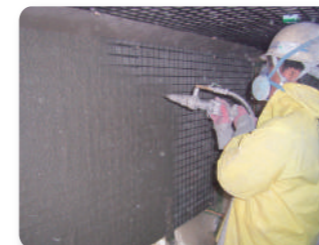
主桁側面増厚補強
