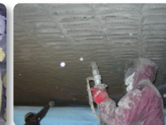
床版下面増厚補強
