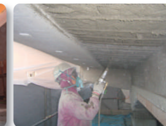
張出床版下面増厚補強
