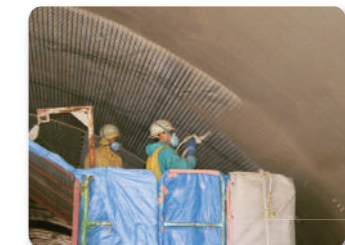
道路トンネル吹付け施工
